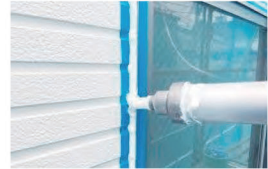
▲シーリング材施工中のガン
