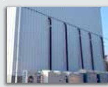
ブレハブ冷蔵庫【外観】
