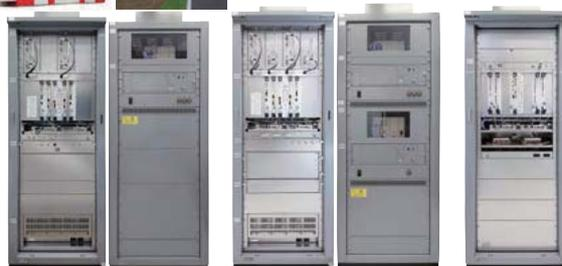
ローカライザー装置 グライド・スロープ装置 T-DME装置
