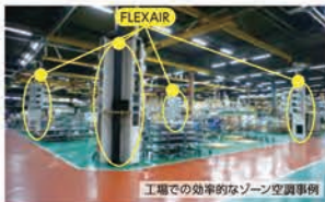
工場での効率的なゾーン空調事例
