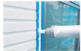
▲シーリング材施工中のガン
